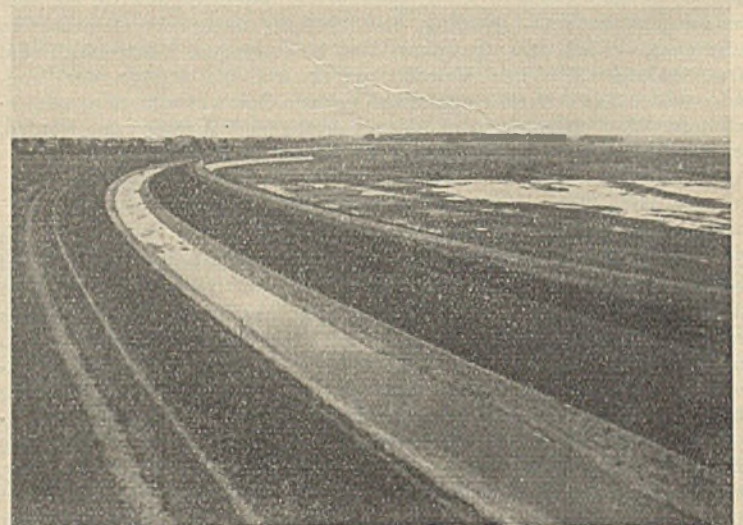
Abb. 1. Blick vom Wärterhaus auf Elsterregelung (links) und Westhälfte des Stausees (rechts).
