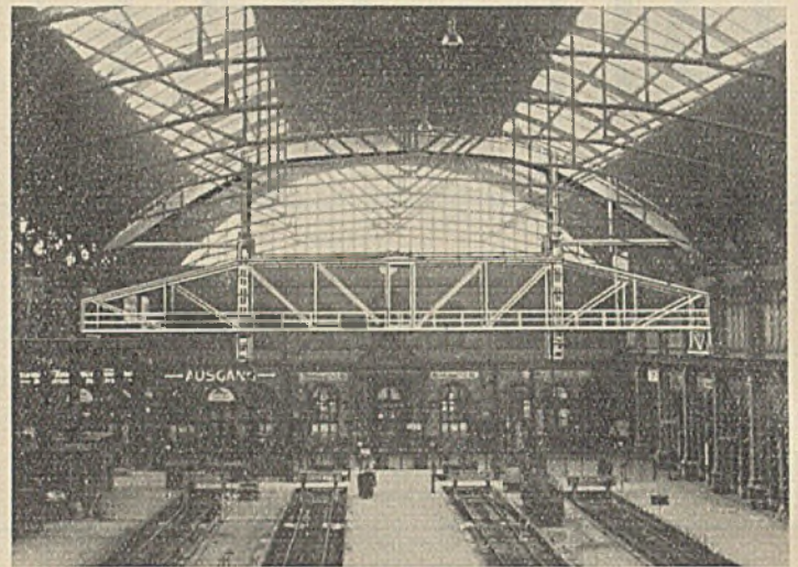
Abb. 4. Fahrbares Besichtigungsgerüst im Hauptbahnhof München (Arbeitsstellung).
