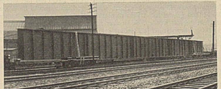
Abb. 9. Fertigeschweißter Träger auf zwei Sonderwagen verladen.
