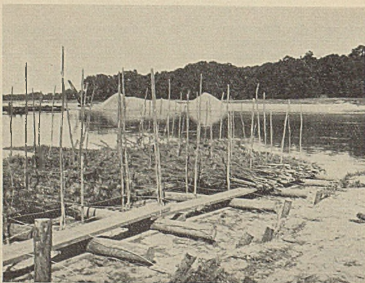
Abb. 5. Herstellung eines Sinkstückes.
