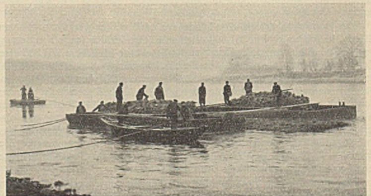
Abb. 6. Versenken eines Sinkstückes.
