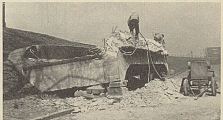
Abb. 7. Der alte Betonüberbau wird abgewrackt.
