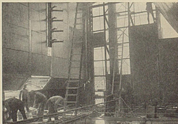
Abb. 26. Schleusen Allerbüttel-Sülfeld. Innenaufnahme der Stahlschalung.
