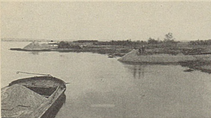
Abb. 19. Neubau einer Zwischenbühne und Bühnenverlängerung i. d. Elbe bei Rothensee.
