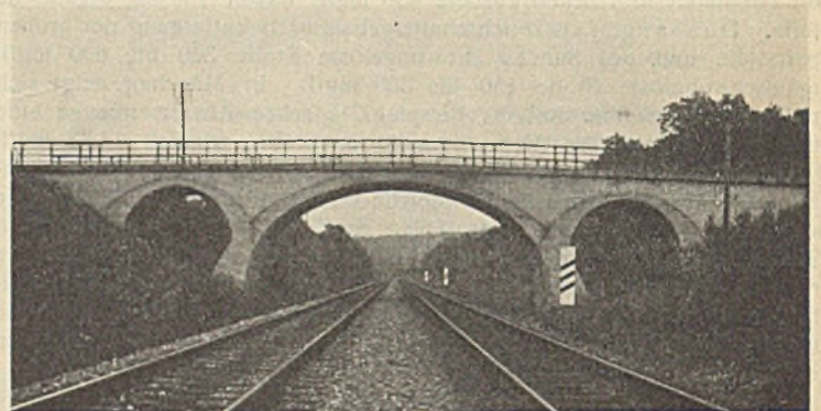
Abb. 4. Gewölbte Wegüberführung vor dem Umbau.
