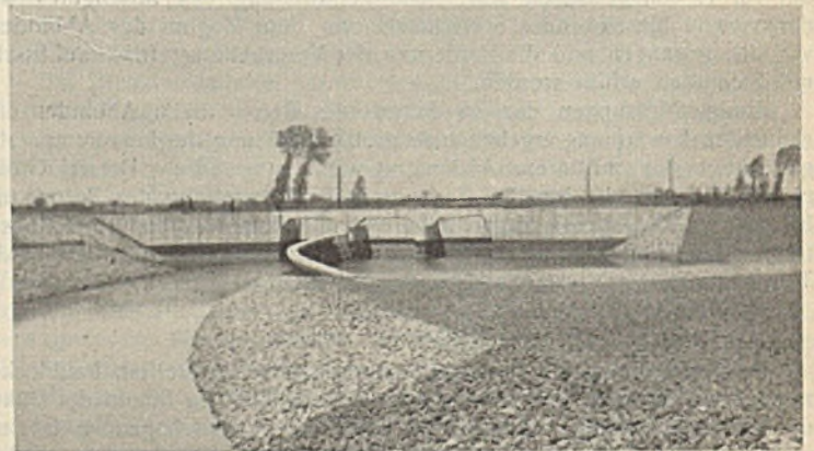
Abb. 29. Ansicht des Dükers vom Einlauf.
