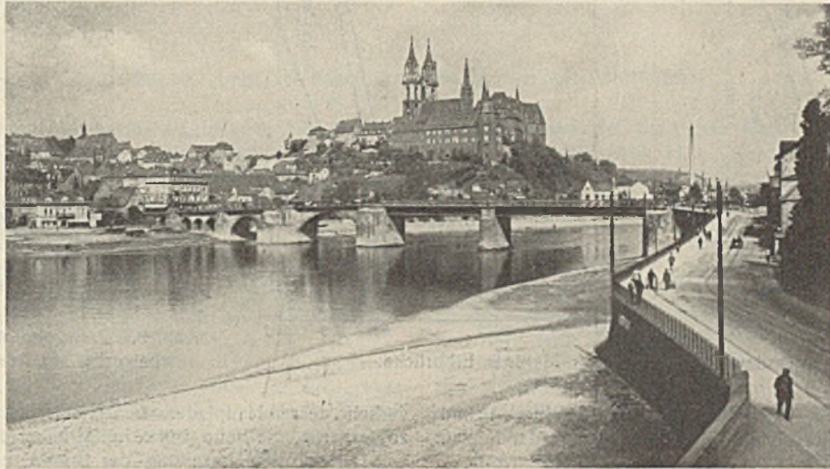
Abb. 1. Blick auf die alte Brücke von oberstrom aus.
