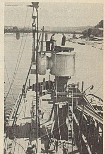
Abb. 24. Absenken Pfeiler II.
