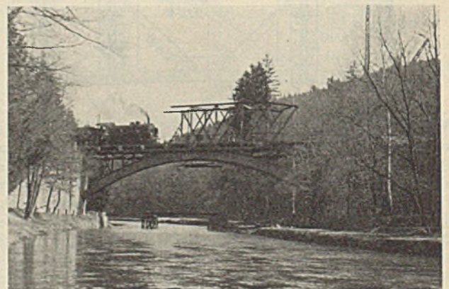
Abb. 20b. Abbruch der alten Hauptträger.
