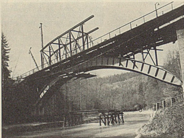
Abb. 20a. Abbruch der alten Hauptträger.
