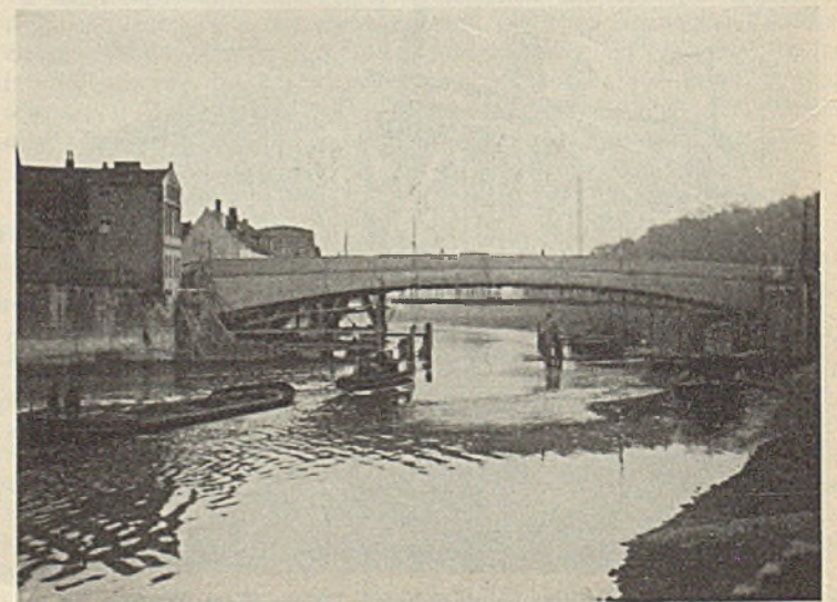
Abb. 43. Saalebrücke Bernburg. Ansicht der Brücke.
