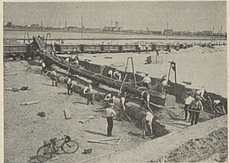
Abb. 36. Verwendung von 27 m langen Gurtförderbändern beim Aushub des Elster-Saale-Kanals im Handschacht. Das Fördergleis liegt in der Mitte des Aushubquerschnitts.
