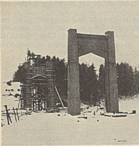
Abb. 14. Pfeiler des Passarge-Viaduktes.
