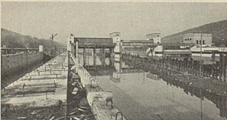
Abb. 77. Staustufe Neckarzimmern. Schleuse, Wehr und Kraftwerk von OW.
