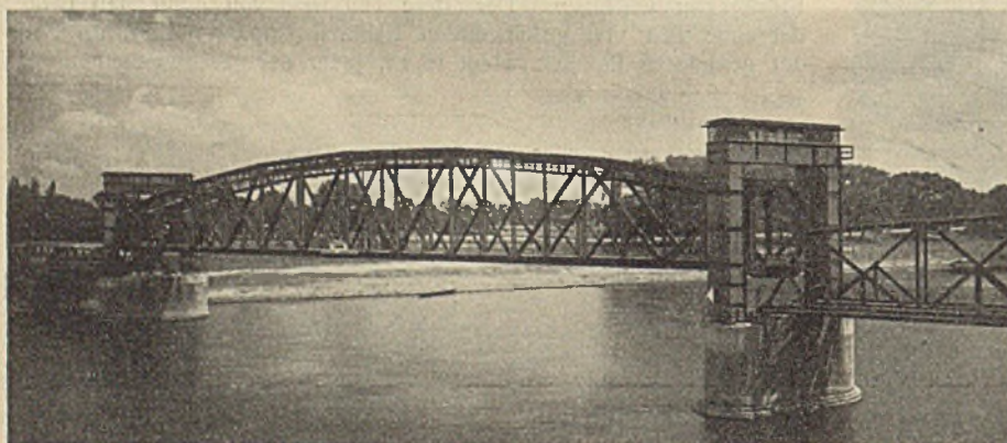
Abb. 32. Hubbrücke bei Magdeburg in gehobener Stellung.
