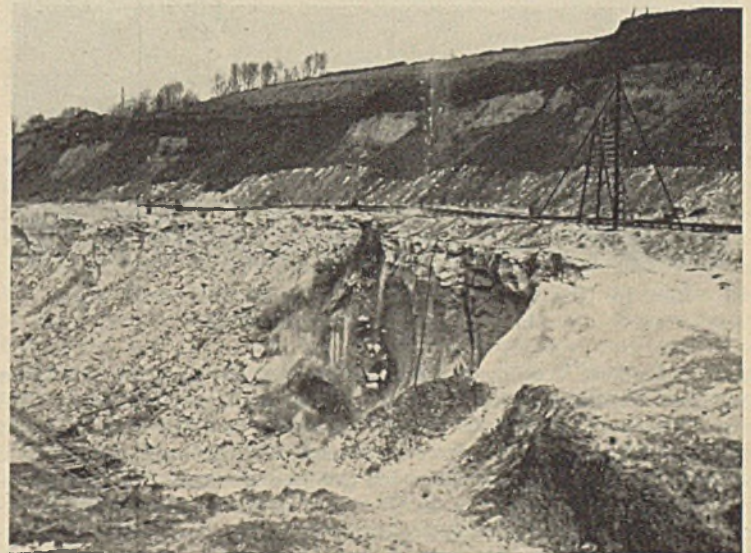
Abb. 14. Die Wirkung der Fels Sprengung mit flüssiger Luft.
