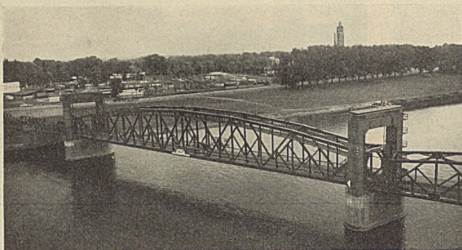
Abb. 31. Hubbrücke bei Magdeburg in tiefer Stellung.
