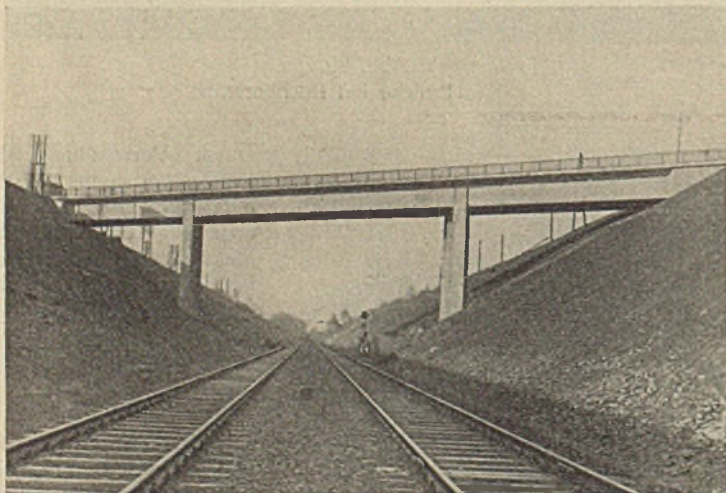
Abb. 35. Straßenüberführung in km 92,977 der Strecke Leipzig—Dresden bei Niederau.
