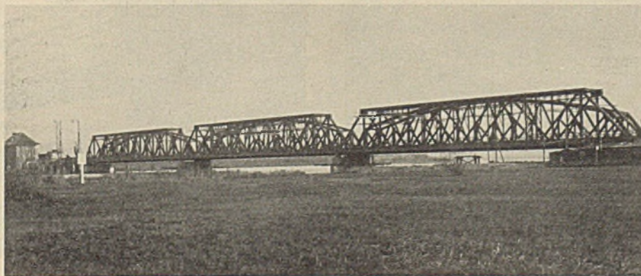
Abb. 28. Brücke über die Große Reglitz bei Podejuch.
