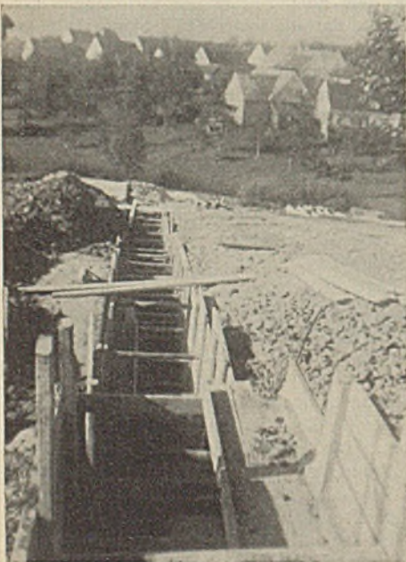
Abb. 4. Offene Baugrube eines 80 m langen Sickerschlitzes.
