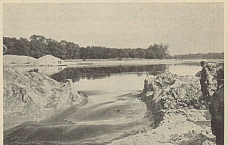
Abb. 20. Wassereintritt in den Durchstich nach dem Öffnen.
