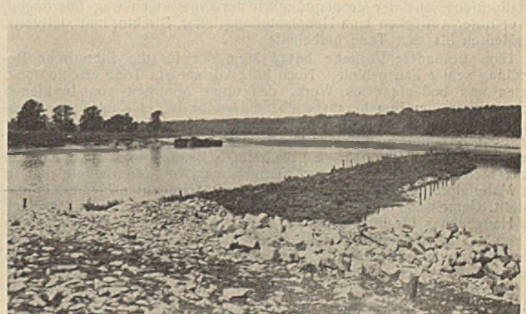
Abb. 23. Buschpackung für das Leitwerk.
