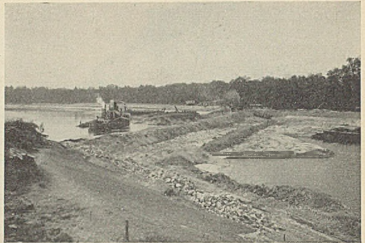
Abb. 18. Der Damm am Durchstichanfang.
