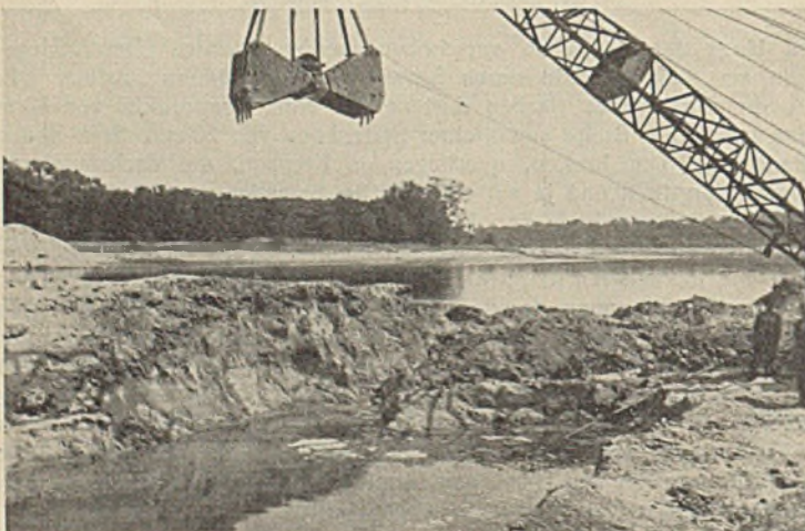
Abb. 19. Öffnen des Durchstiches durch einen Greifer.
