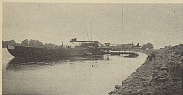
Abb. 15. Schotterverteilungsanlage im Betrieb.
