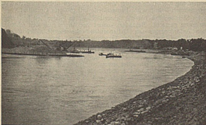
Abb. 22. Herstellung des Verbaues durch Greifbagger.
