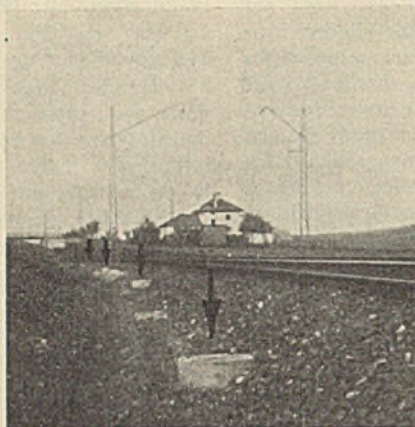
Abb. 10. Reinigungschächte einer TE, die im Abstände von 25 m angeordnet sind.
