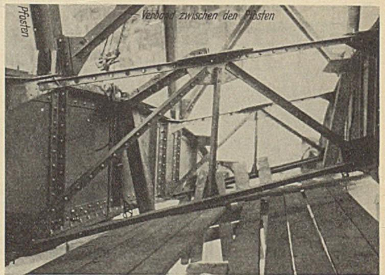
Abb. 13. Querverbände zwischen den Zweigelenbogen.
