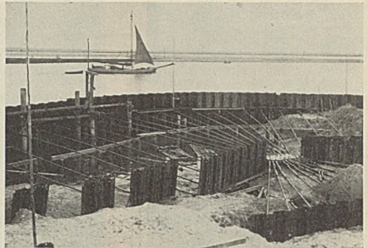
Abb. 6. Blick auf die Verankerung.
