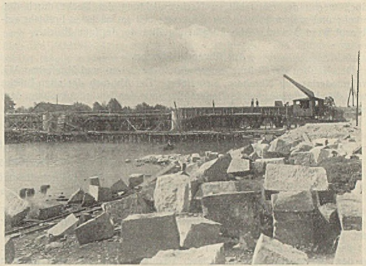
Abb. 9. Überblick über die Baustelle.
