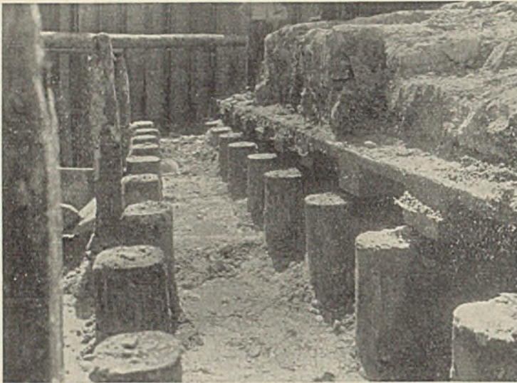
Abb. 5. Abbruch des rechten Widerlagers. Der alte Holzpahlrost.
