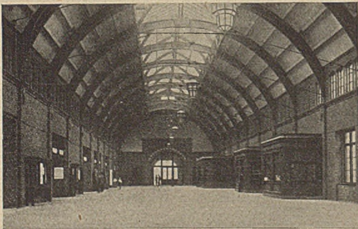
Abb. 7. Inneres der Querhalle.
