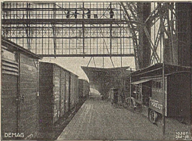
Abb. 5. Sandstrahlgebläse auf einem Bahnsteig in Frankfurt a. M.
