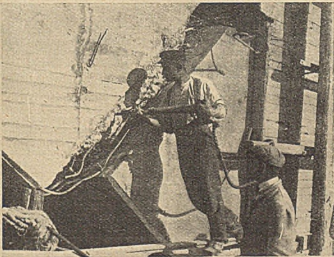
Abb. 3. Die zerquetschte Kämpferlamelle.
