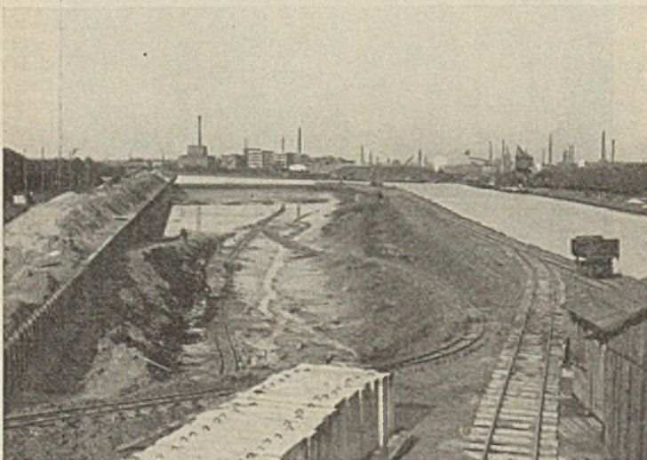
Abb. 52. Ausgrabungen im Handschacht zur Herstellung eines Hafens bei der Zeche Viktor.
