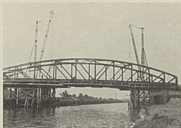
Abb. 56. Schließen des eisernen Überbaues einer neuen Brücke durch Einhängen der Zwischenstücke.
