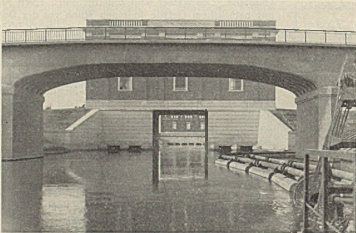
Abb. 6. Entnahmeanlage bei Boretto. Blick unter der Brücke durch nach der 1. Schleuse.
