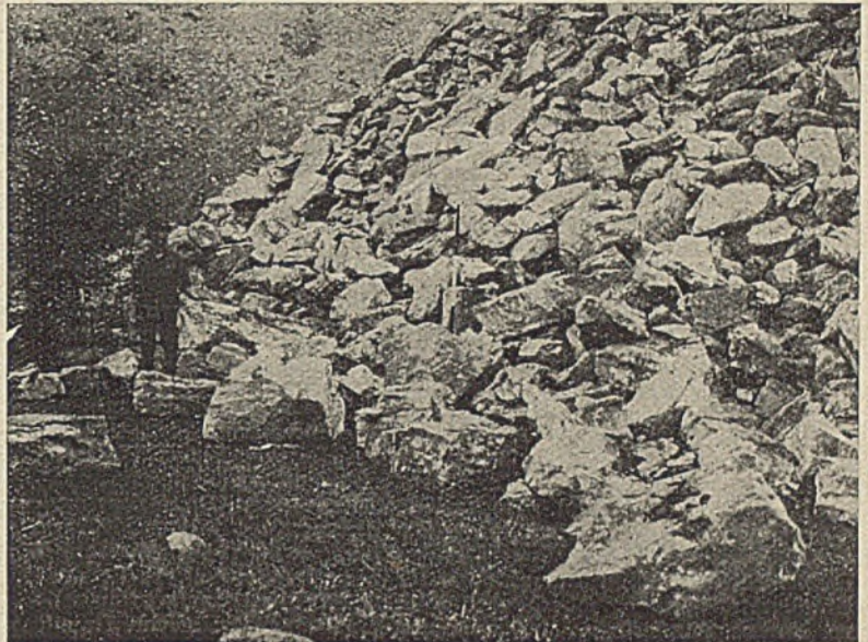
Abb. 8. Vom 2 m 3 -Löffelbagger bewältigte schwere Gesteinsmassen.
