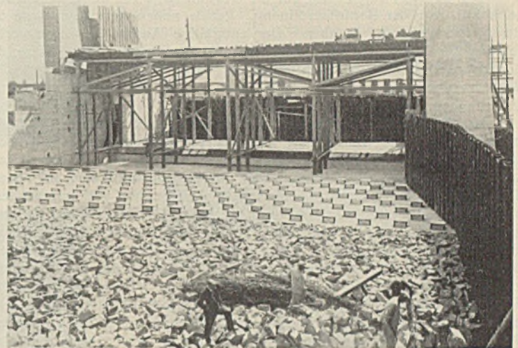
Abb. 66. Blick in die Baugrube der rechten Wehrröffnung der Staustufe Kostheim.
