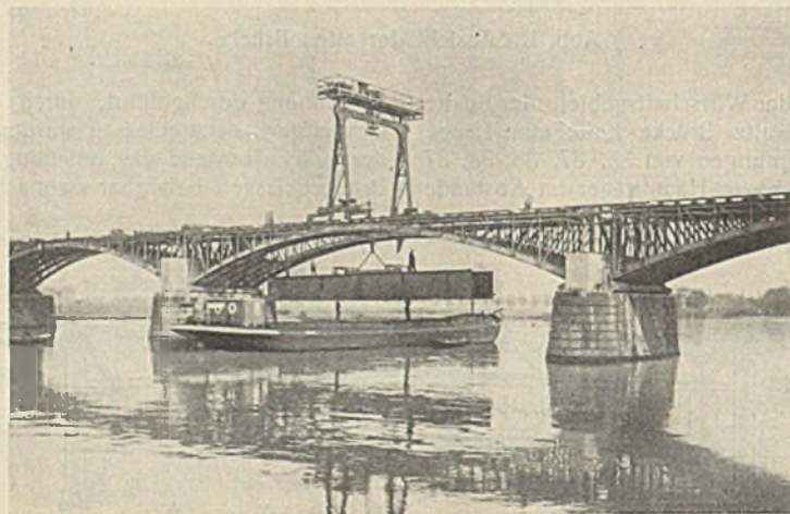
Abb. 7. Montage der neuen Hauptträger.
