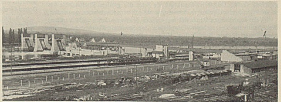
Abb. 65. Ansicht der Staustufe Eddersheim kurz vor der Betriebseröffnung.
