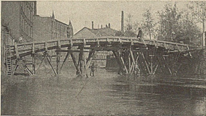
Abb. 5. Ansicht des Lehrgerüsts.
