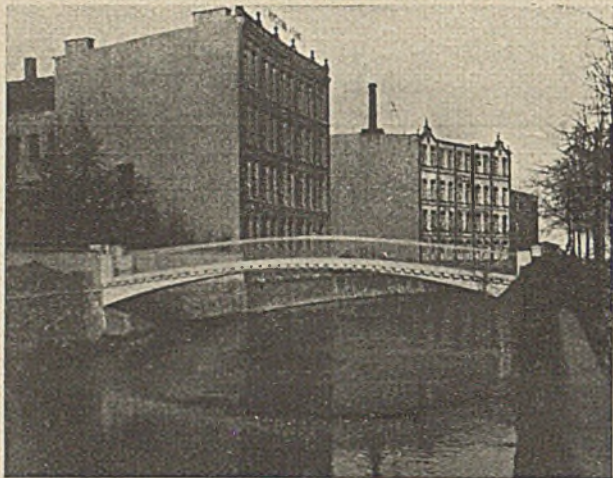
Abb. 1. Ansicht der Brücke.
