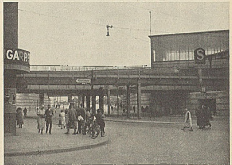
Abb. 2b. Die Unterführungen nach dem Umbau von der Tempelhofer Straße aus gesehen.
