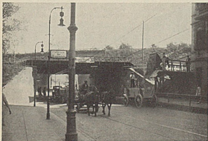
Abb. 2a. Die Unterführungen vor dem Umbau von der Tempelhofer Straße aus gesehen.
