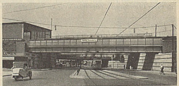
Abb. 3b. Die Unterführungen nach dem Umbau vom Sachsendamm aus gesehen.
