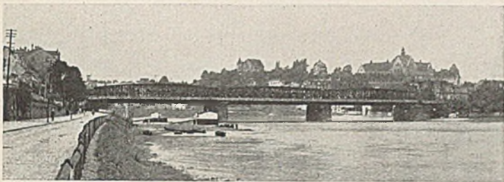
Abb. 45. Die alte Brücke von stromaufwärts gesehen.
