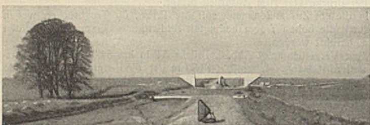
Abb. 8. Brücke 1 in km 0,2 + 85.
