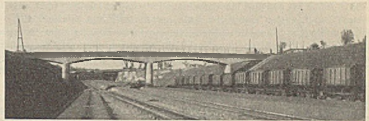
Abb. 9. Brücke 4 in km 1,6 + 34.
