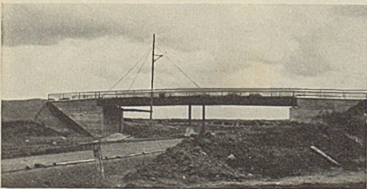
Abb. 25. Bauwerk 65, Wegüberführung in km 87,7 + 25.
