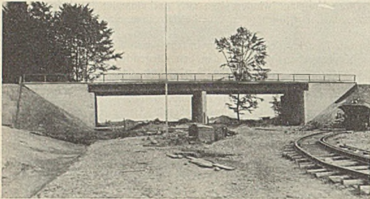
Abb. 23. Bauwerk 14, Straßenüberführung in km 19,4.
