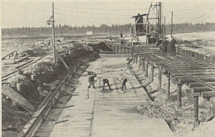
Abb. 28. Sohlenschwelle Lech km 54,4. Bauteil I: Aufnageln des Bohlenbelages.
