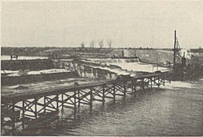
Abb. 24. Bauteil II: Versatz, Spülwandramme.
