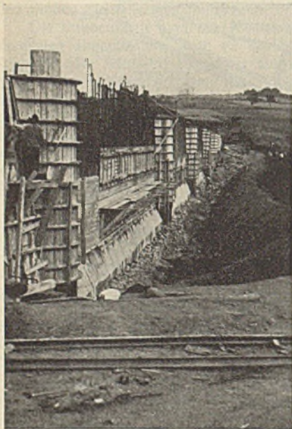
Abb. 8. Betonierung der Kernmauer mit luftseitiger Steinpackung.
