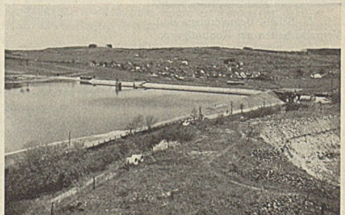
Abb. 10. Unterer Teil des Staubeckens mit Staudamm. Im Hintergrunde die Ortschaft Driedorf.
