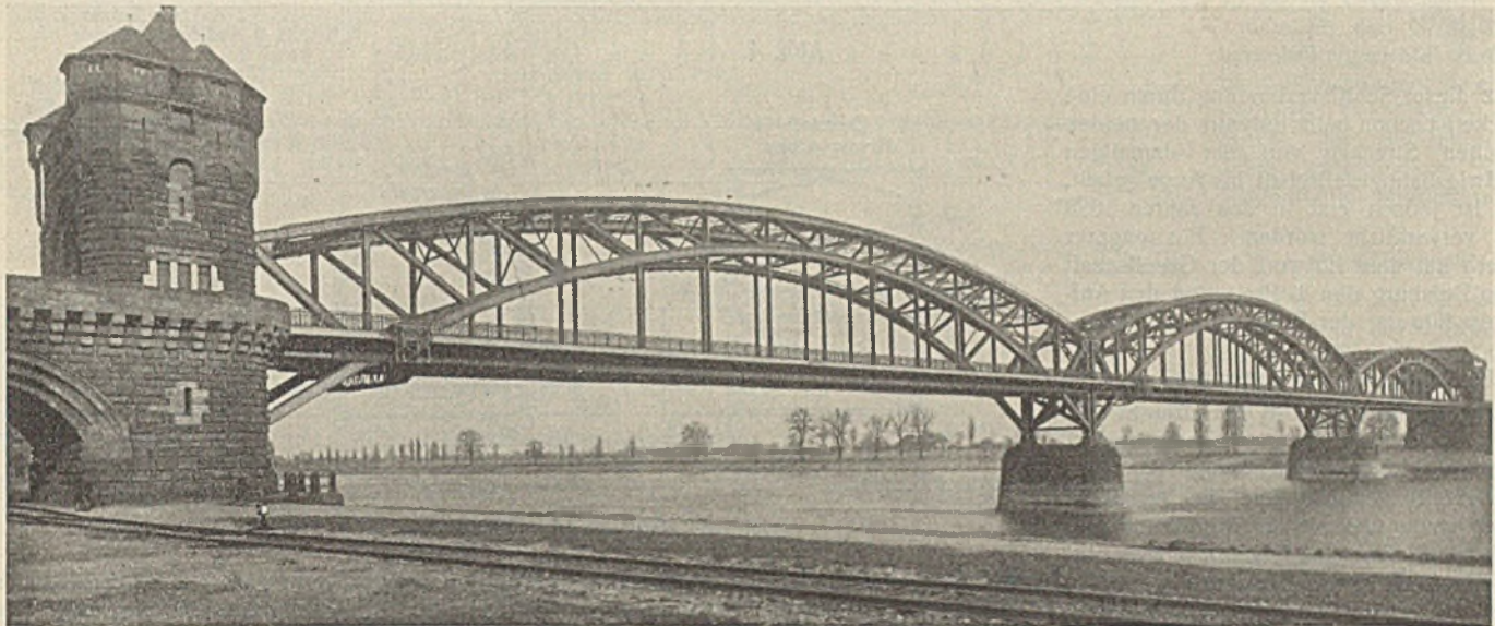
Abb. 1. Ansicht der verstärkten Strombrücke.
