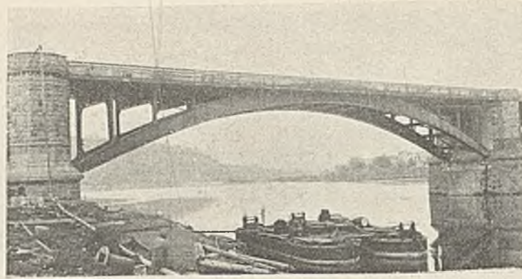
Abb. 13. Brücke über die Mosel bei Güls.
