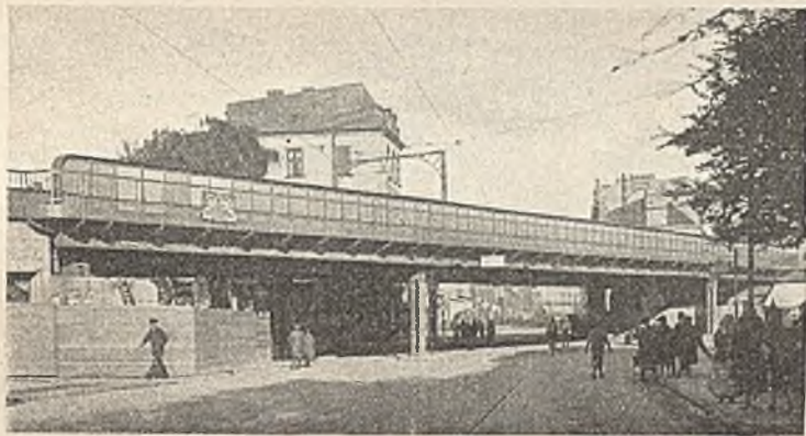
Abb. 10. Brücke am Stern in Altona.
