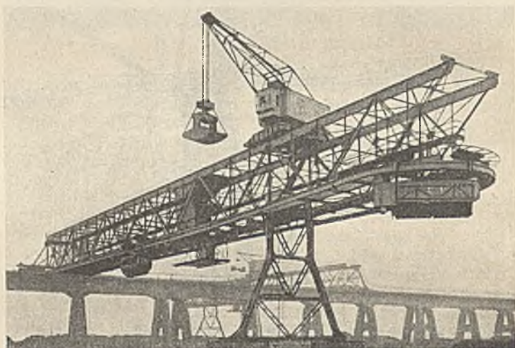
Abb. 7. Betonhochbahn und Verladebrücken mit Drehkränen auf dem Lagerplatz.
