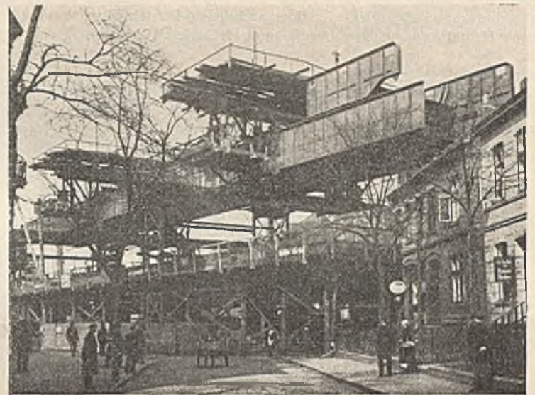
Abb. 11. Brücke am Stern in Altona im Bau.
