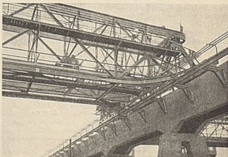
Abb. 8. Anschluß der Lagerplatzbrücke an die Betonhochbahn.
