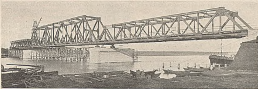
Abb. 3. Brücke über die Ostoder bei Stettin.
