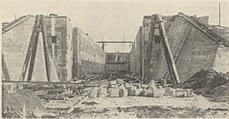
Abb. 2. Schleuse Barkow vom Unterhaupt aus gesehen.
