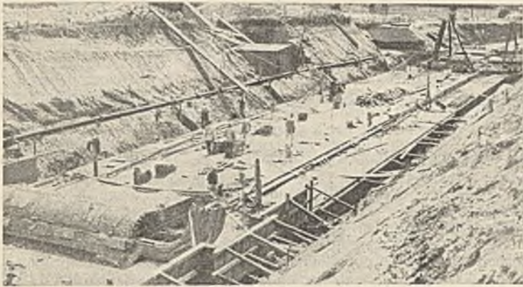
Abb. 1. Betonieren der Kammersohle für die Schleuse von Barkow.
