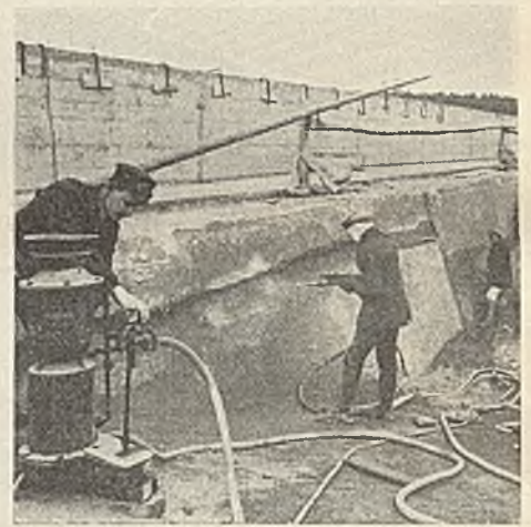
Abb. 11. Risse an Gewölbestirnmauern der Innenseite werden austorkretiert.
