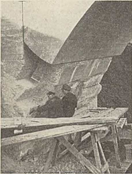
Abb. 7. Ausstemmen von Verzahnungen am südlichen Landlager. (Siehe alte senkrechte Arbeitsfuge!)
