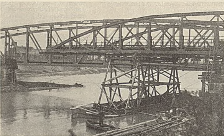
Abb. 4c. Das Schiff und Gerüst wird nach der Überfahrt gegen das Widerlager abgesteift. Im Hintergrunde die neue Brücke.
