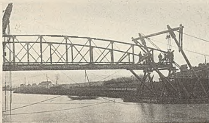
Abb. 3b. Das rechte Ende ist kurz vor dem Anlandschieben der Brücke auf das Schiffsgerüst abgesetzt. Die Flaschenzüge werden gerade von dem Obergurte gelöst.
