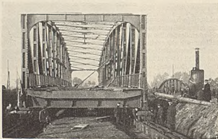
Abb. 2d. Rechtes Brückennende. Rollenlager und Rollbahn. Umlegen der Walzen während des Überschiebens.
