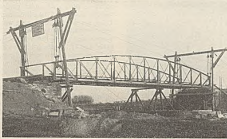
Abb. 3a. Abheben des rechten Brückenendes von dem Widerlager.
