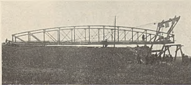
Abb. 3c. Abheben des rechten Brückenendes vom Schiff nach dessen Ankunft am linken Ufer.
