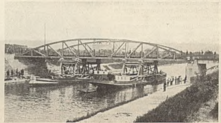
Abb. 1d. Die Brücke nach dem Eintreffen an der neuen Stelle.
