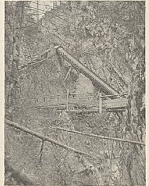
Abb. 6. Holzrohrleitung am Ende der Schlucht.
