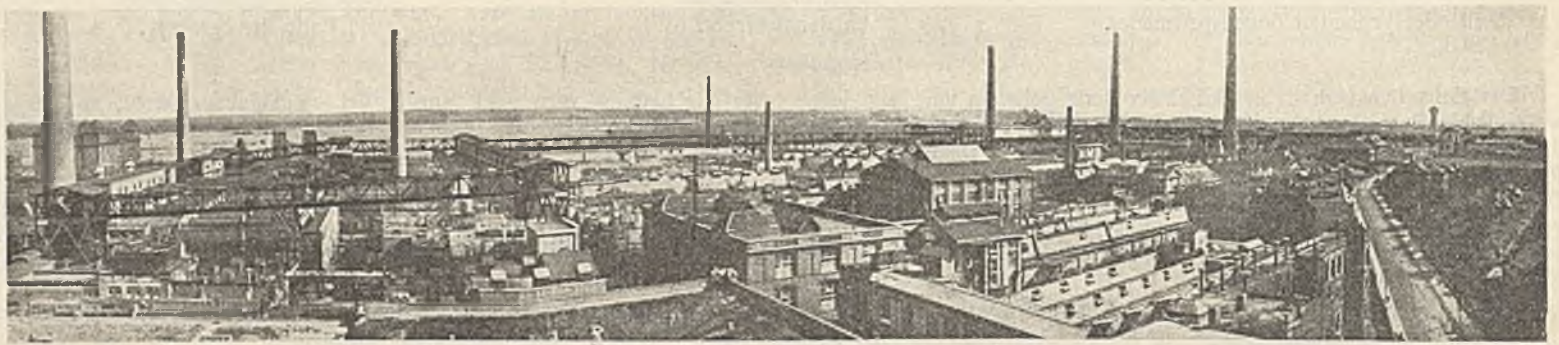
Abb. 11. Teilansicht der Kohlen-Förder- und -Lageranlagen der Höchstler Farbwerke.
