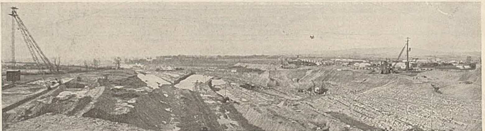
Abb. 6. Ansicht der Hauptbaueinrichtung mit durch Eimerkettenbagger ausgehobener Baugrube des späteren Kraftwerkes. Blick nach dem Untergraben.
