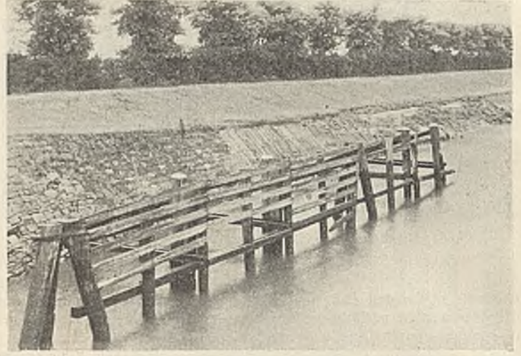
Abb. 2. Leitwerk aus Dalben vor dem Unterhaupt der großen Schleuse.
