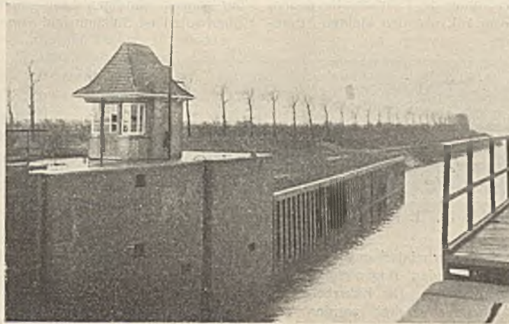
Abb. 7. Neues Leitwerk vor dem Unterhaupt der großen Schleuse aus Larssen-Spundwänden, von der Kaimauer aus gesehen.
