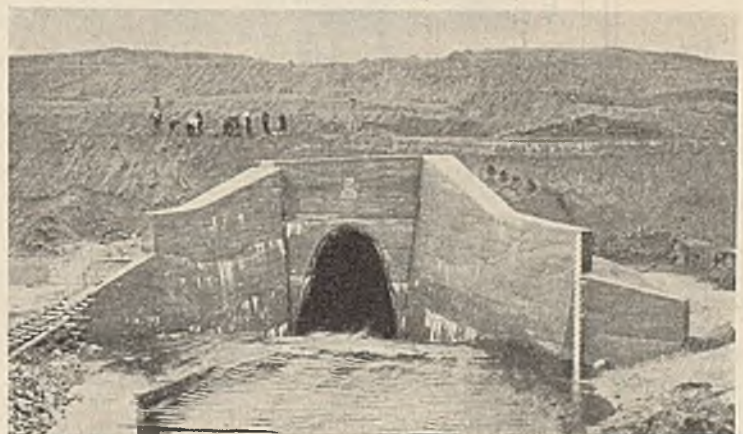
Abb. 11. Einlauf des ersten fertiggestellten Kunstbaues: Blackwaterducker mit 50 m 3 /Sek. Durchflußleistung unter 18 m hohen Kanaldämmen.
