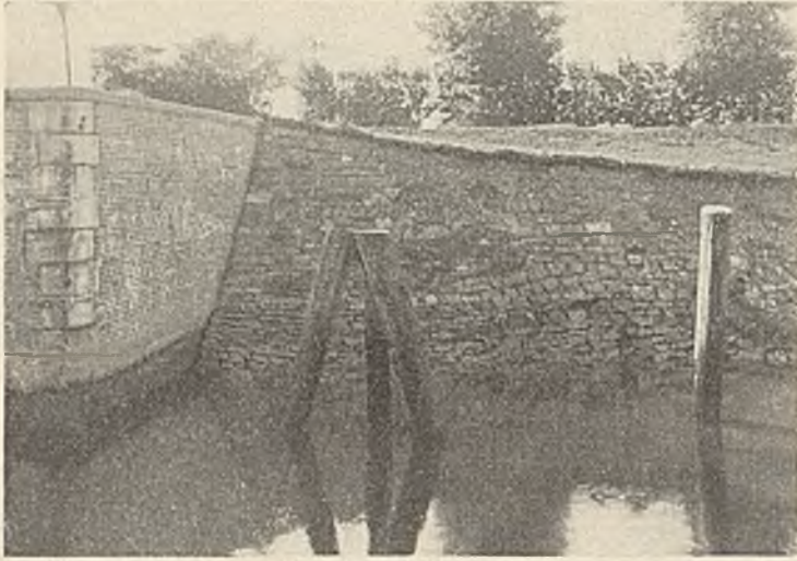
Abb. 1. Dalben vor dem Unterhaupt der großen Schleuse.
