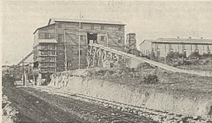
Abb. 8. Brech- und Waschanlage für Schotter, Splitt und Sand in Ardnacrusha. Rechts das Baukraftwerk.
