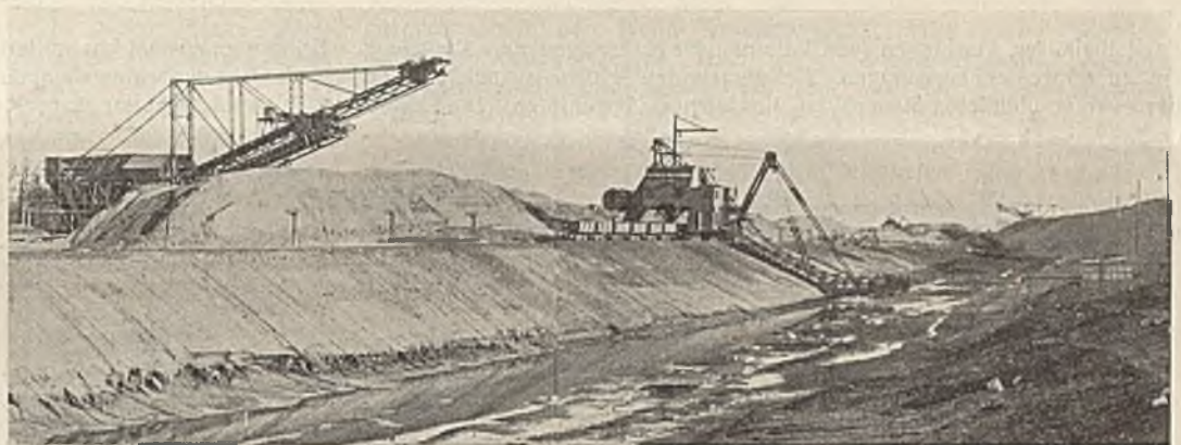
Abb. 10. Aushub des Oberkanals durch zwei elektrische Eimerkettenbagger und Schütten der Dämme durch zwei Absetzmaschinen.
