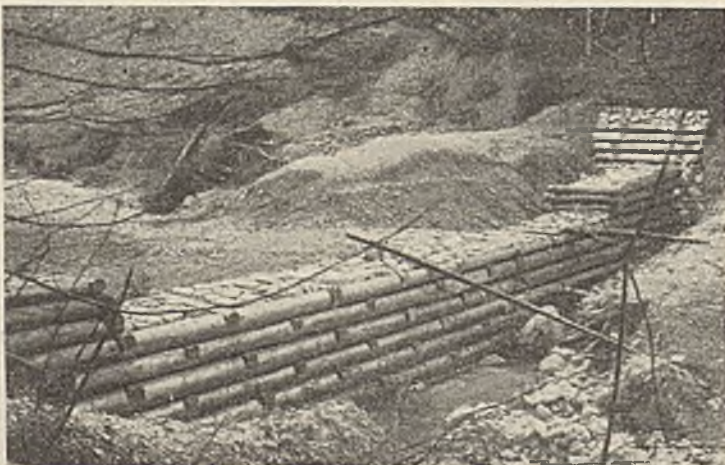
Abb. 44. Querwerk (Steinkasten) im Weißenbachtal.
