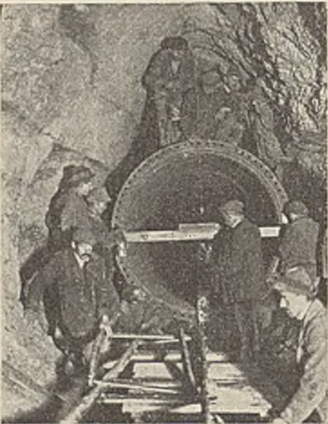
Abb. 38. Einbringen eines Flanschrohres in den unteren wagerechten Teil des Druckschachtes.
