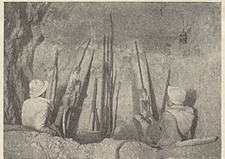
Abb. 16. Bohrhammerbetrieb während des Schütterns.
