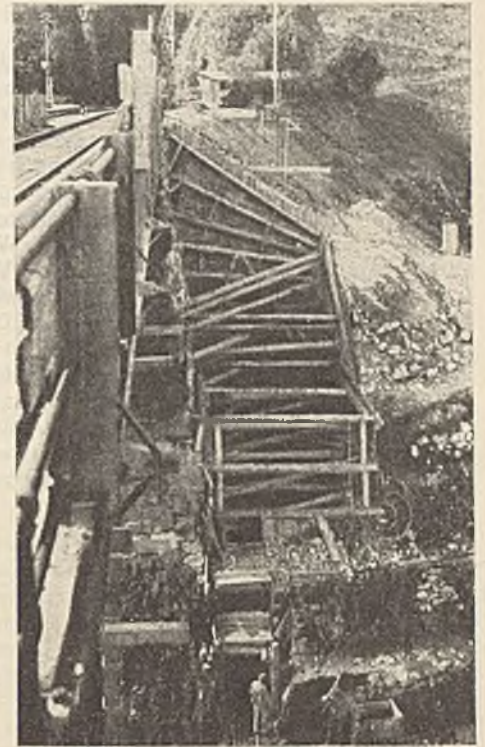
Abb. 10. Auszimmerung der Baugrube für das nördliche Widerlager der Brücke unter Gleis 3.
