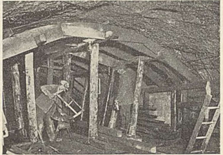
Abb. 30. Schalung für die Firstbetonierung im Wasserschloß.
