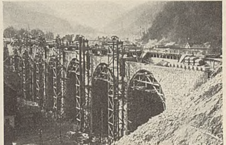
Abb. 16. Senktürme und Lehrgerüste.
