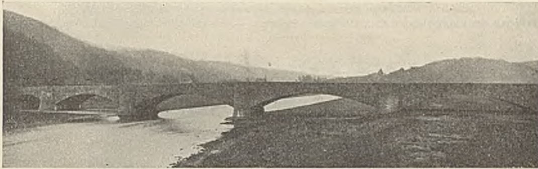
Abb. 1. Straßenbrücke über die Sieg bei Allner. Betonbogen mit Hausteilverkleidung. Ausführung 1925/1926 durch die Firma Hüser & Cie., Obercassel-Siegkreis.
