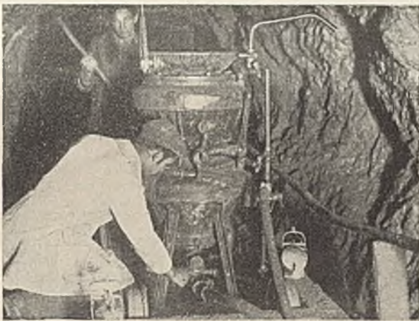
Abb. 24a. Mörtelhinterspressung mit Injektionsapparat (System Torkretgesellschaft).
