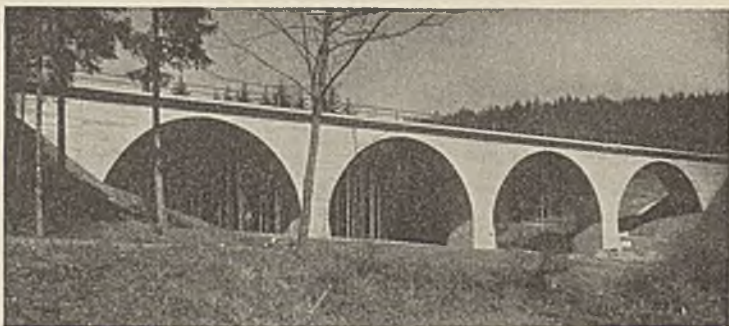
Abb. 3. Aispachviadukt auf der Bahnlinie Leinfelden—Waldenbuch bei Stuttgart. Ausgeführt 1922 durch die Firma Wayss & Freytag. Außenflächen unbearbeiteter Vorsatzbeton.
