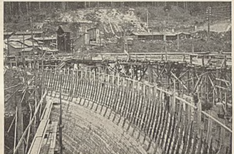
Abb. 13. Betonierung der Staumauer mittels fliegender Schalung.
