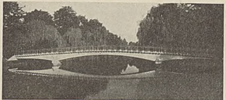
Abb. 4. Fußgängerbrücke Ostrowerweg Cottbus. Ausgeführt 1923 durch die Firma Dyckerhoff & Widmann. Außenflächen abgestockt, jedoch ohne Vorsatzbeton.
