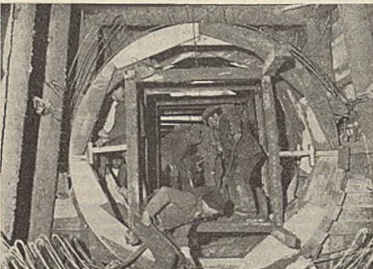
Abb. 31. Betonierung des Überlaufstollens.
