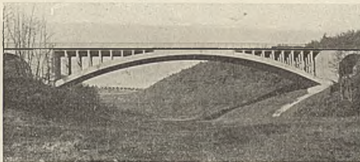
Abb. 2. Straßenbrücke im Wahnbachtal bei Siegburg. Stampfbetonbogen ohne Verkleidung und ohne Vorsatzbeton. Ausführung 1925 durch die Firma Hüser & Cie., Obercassel-Siegkreis.
