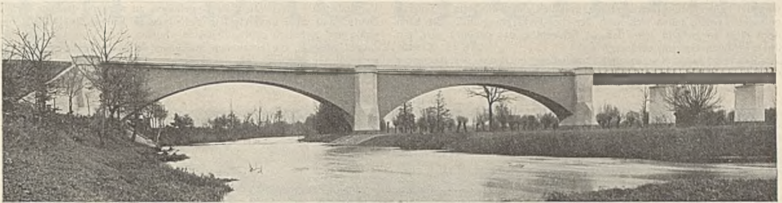
Abb. 10. Eisenbahnbrücke über die Elster, Güterzuglinie Techwitz—Zeitz.
