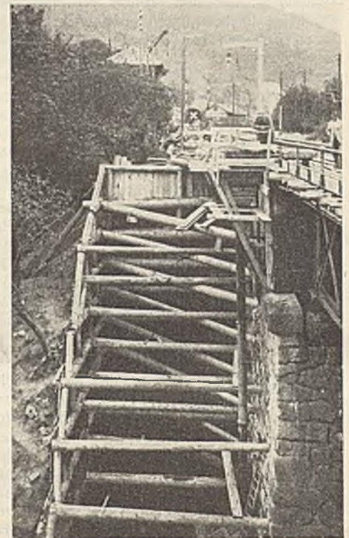
Abb. 12. Auszimmerung der Baugrube für das südliche Widerlager der Brücke unter Gleis 3.
