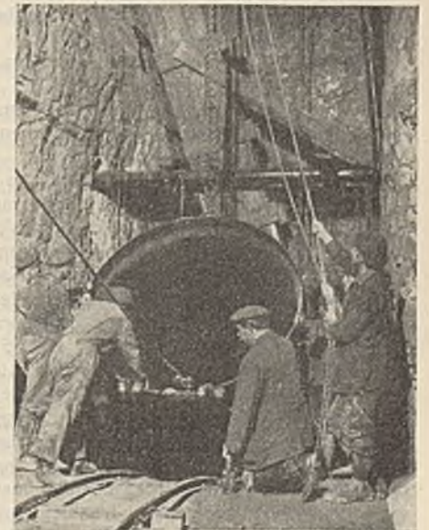
Abb. 36. Ablassen eines Muffenrohres in den Schrägschacht.
