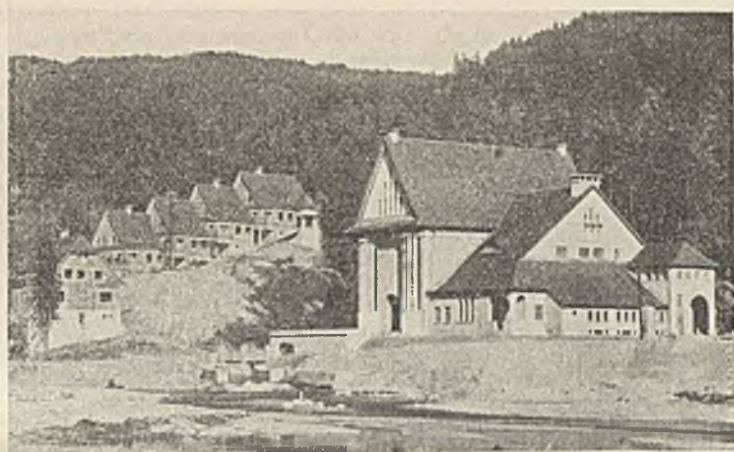
Abb. 4. Kraftthaus mit Maschinistenwohnhäusern.
