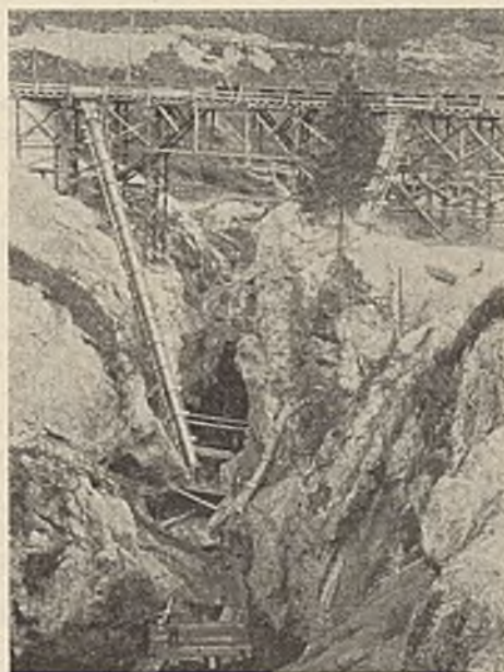
Abb. 7. Arbeitsbrücke über die Strubklamm für die Staumauerbetonierung.
