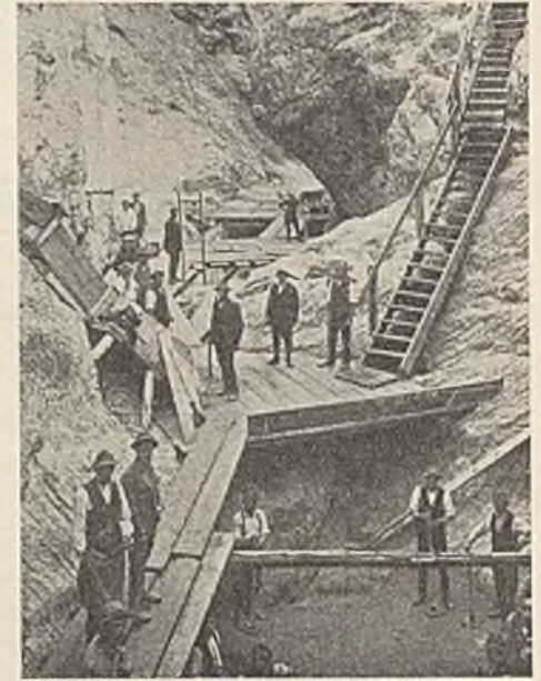
Abb. 12. Staumauerbetonierung in der Strubklamm.
