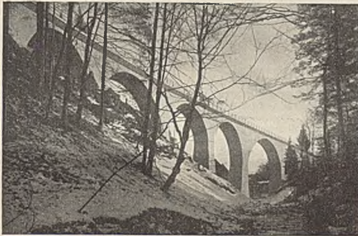
Abb. 13. Laufenmühle-Viadukt auf der Strecke Schorndorf—Welzheim (Württemberg).
