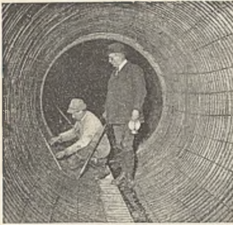
Abb. 23. Verlegte Spiralbewehrung.
