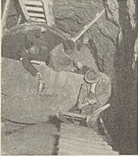
Abb. 37. Einbetonieren eines Muffenrohrs im Druck- (Schräg-) Schacht.
