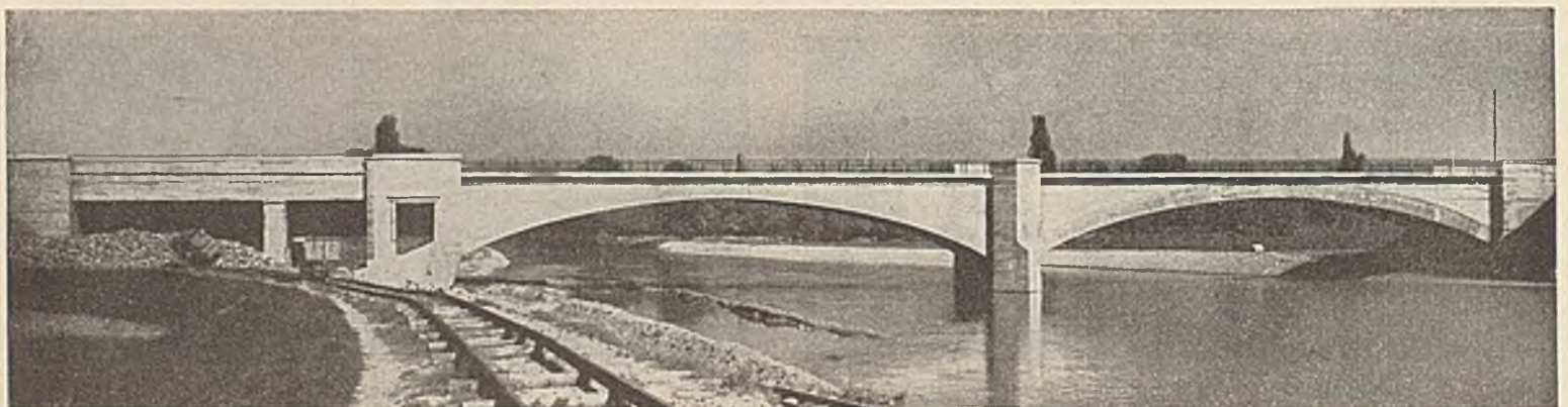
Abb. 9. Eisenbahnbrücke mit Gehweg über den Neckar bei Stuttgart-Gaisburg. Ausgeführt 1922 durch die Firma Wayss & Freytag. — Ansichtflächen unbearbeiteter Vorsatzbeton.
