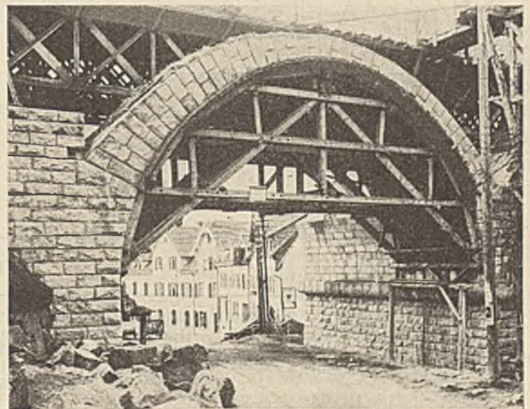
Abb. 19. Lehrgerüst in Öffnung 7 der Brücke unter Gleis 3.
