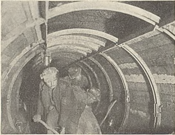
Abb. 20. Stollenbetonierung. Zweiteilige eiserne Lehrbogen mit Holzverschalung. Im Scheitel Blechtafeln, quer verlegt für Gewölbeschluß.
