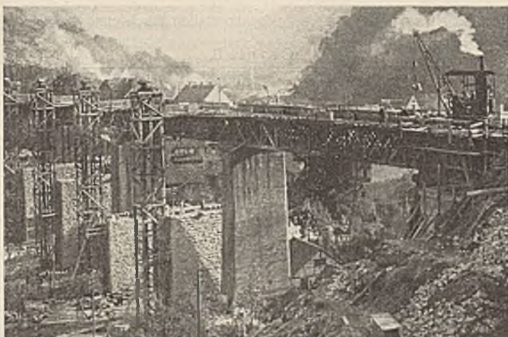
Abb. 14. Senktürme und Lehrgerüste.
