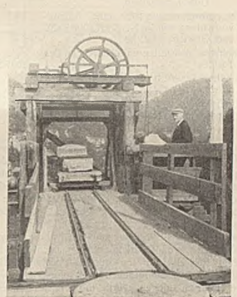
Abb. 17. Senk- und Aufzugvorrichtung auf dem Senkturm.
