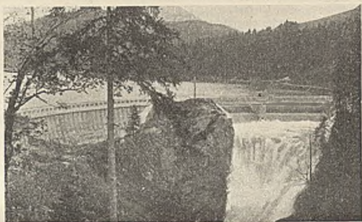
Abb. 3. Staumauer mit Hochwasserüberfall.
