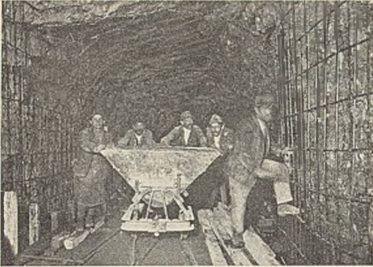
Abb. 29. Kreuzbewehrung im Wasserschloß.
