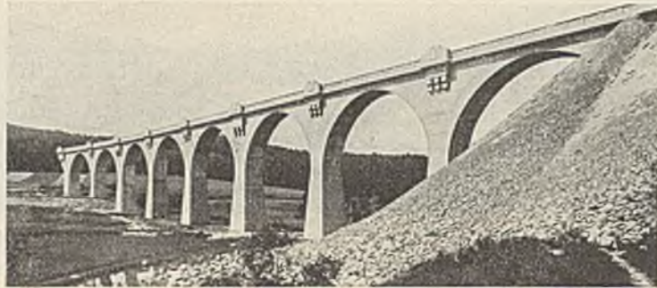
Abb. 6. Eisenbahntalbrücke bei Eifa auf der Linie Niederaula—Alsfeld. Ausgeführt 1912 durch die Firma Hüser & Cie., Obercassel-Siegbkreis. Ansichtflächen ohne Steinverkleidung.
