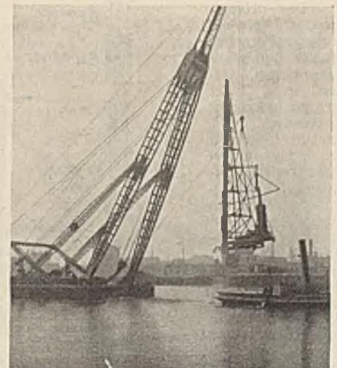
Abb. 9. Vortrag Piel: Kaimauer Vlissingen. Verladen einer Pfahlramme.
