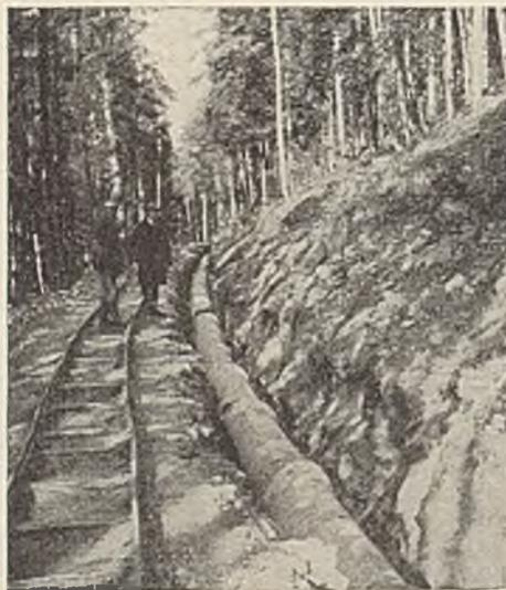
Abb. 12. Kraftwerk Gausbach. Hangrohrleitung aus Vianinirohren.
