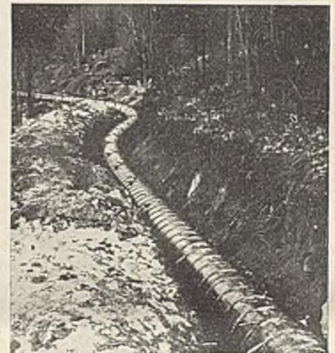
Abb. 11. Kraftwerk Sasbachwalden. Hangrohrleitung aus Holz.
