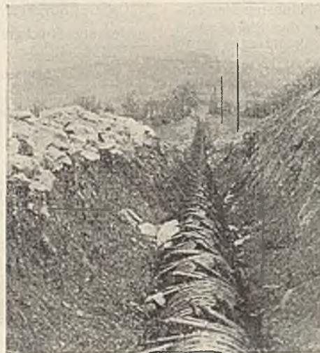
Abb. 10. Kraftwerk Lauf. Fallrohrleitung aus Holz.
