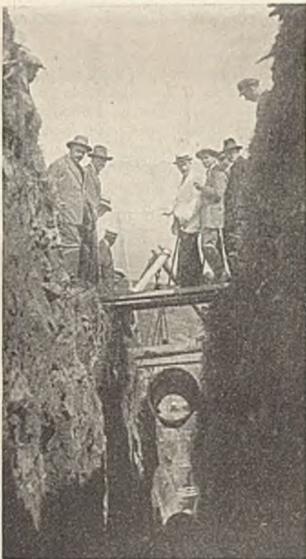
Abb. 6. Verlegen eines eisernen Rohres.
