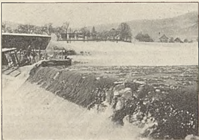
Abb. 2. Dachwehr in der Aupa bei Eisgang.
