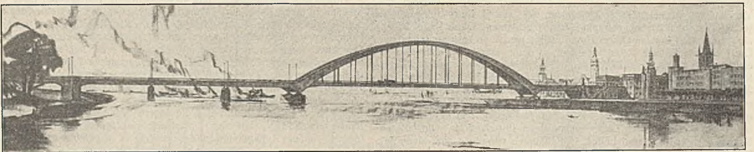
Abb. 50. Entwurf: „Drei goldene Kronen“. Entwurf III. Parabelbogen mit Zugband. Übersicht der Strombrücke.
