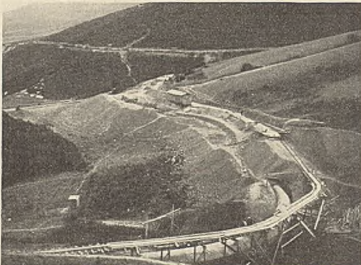
Abb. 3. Verlauf der Linie des Betonkanals.
