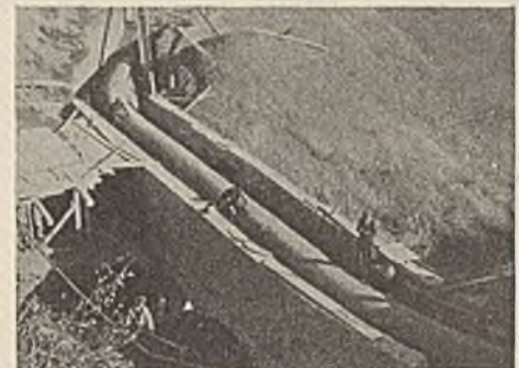
Abb. 8. Gewölbte Brücke mit Betonkanal.
