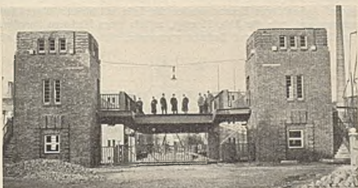
Abb. 20. Gehobene Brücke von der Straße gesehen.
