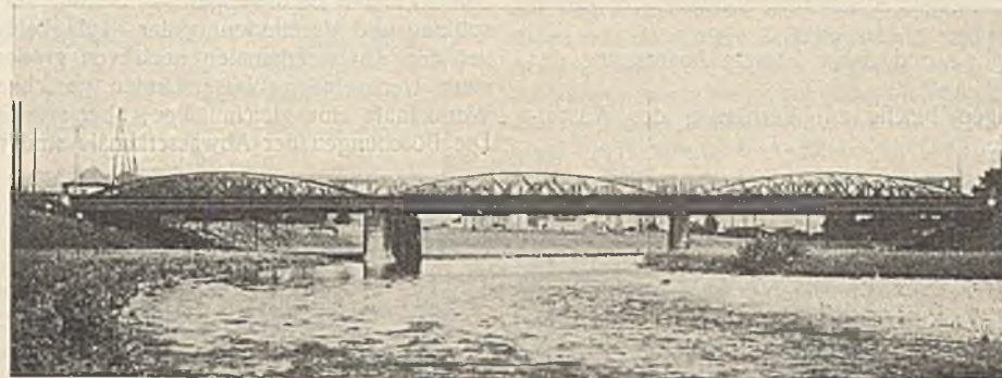
Abb. 5. Ansicht von Westen (flußabwärts).
