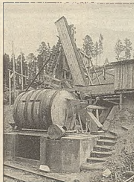
Abb. 6. Sandrückgewinnungsmaschine der Internationalen Baumaschinenfabrik A.-G. (Schwarzenbachtalsperre).
