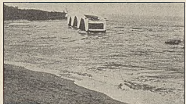
Abb. 1. Aufnahme der Durchbruchstelle mit freistehender Brücke.
