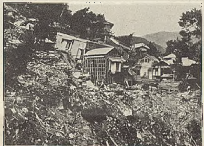
Abb. 2. Abrutsch an einem Steilhang (Dorf Sokokura im Berglande von Hakone, Japan).
