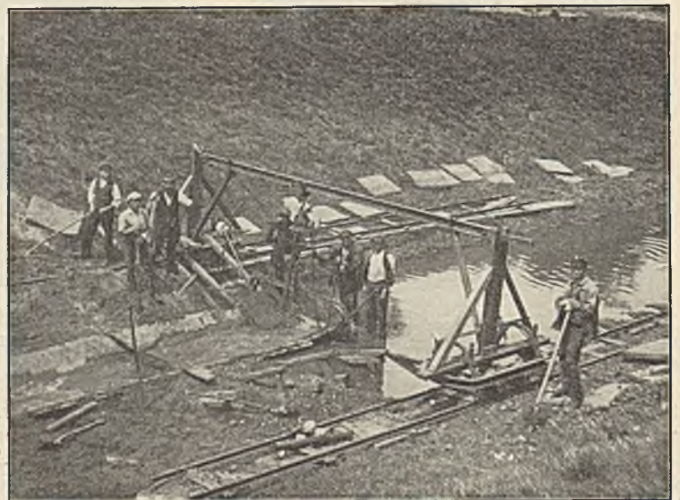
Abb. 6. Hebung einer durch Bergbau gesunkenen Bachstrecke.
