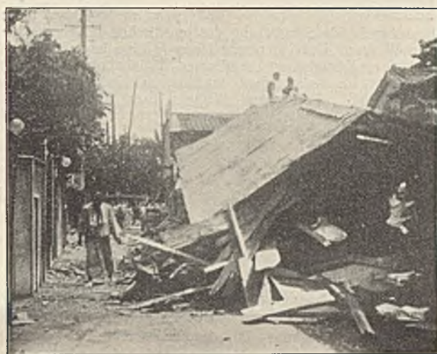
Abb. 14. Die charakteristische Zerstörungsform japanischer Holzhäuser: Zusammenklappen des Unterbaues bei unversehrtem Dach.
