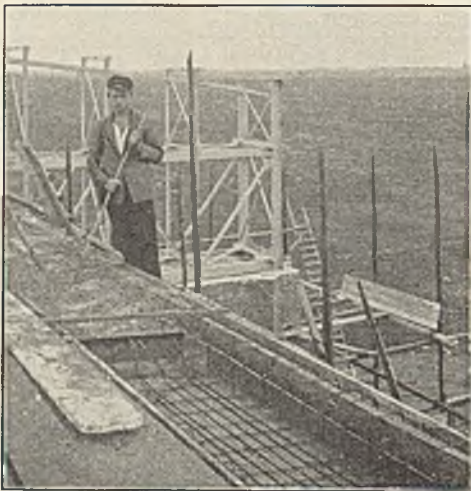
Abb. 4. Herstellung des Eisenbeton-Dachgesimses der Halle.
