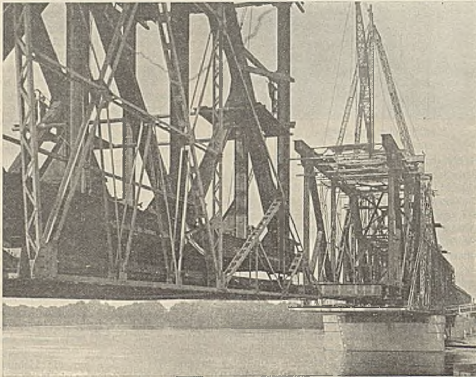
Abb. 8. Freier Vorbau der Mittelöffnung.
