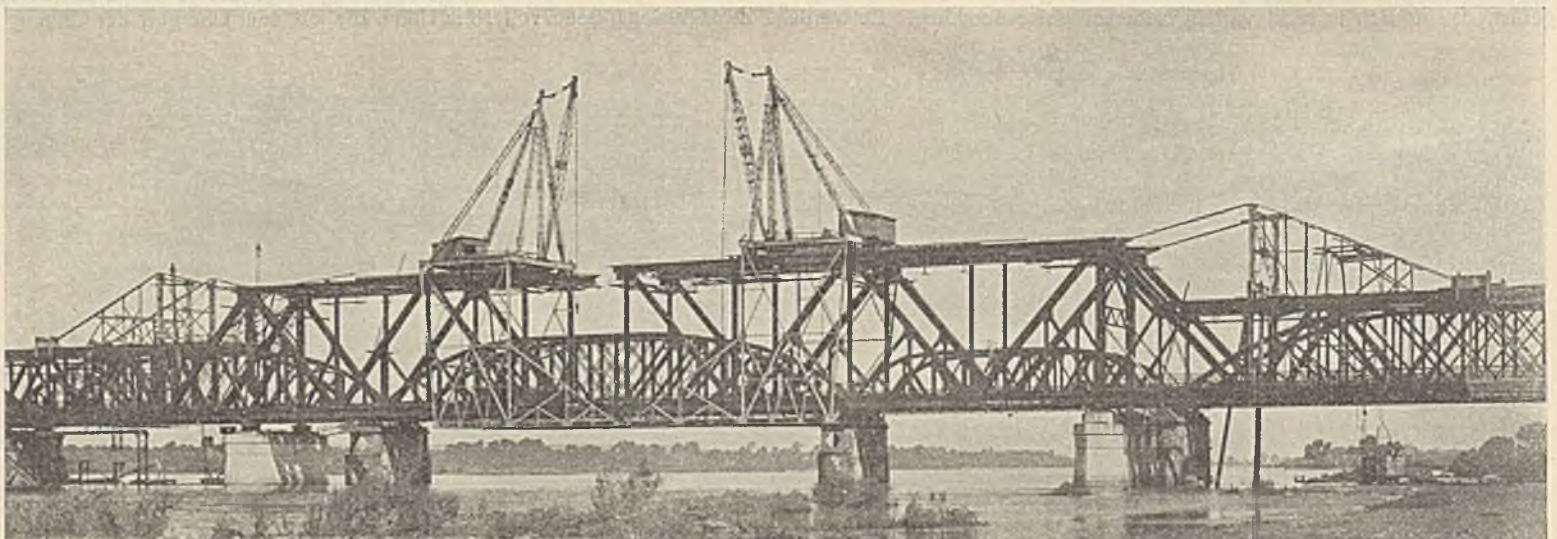
Abb. 9. Freier Vorbau der Mittelöffnung, fertig bis auf das Schlußfeld.
