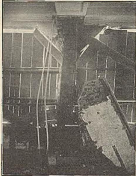
Abb. 20. Palasthotel in Tokio. Eine ausgebogene Säule (Profil etwa entsprechend I 30 B, Maß der Abbiegung 30 cm).
