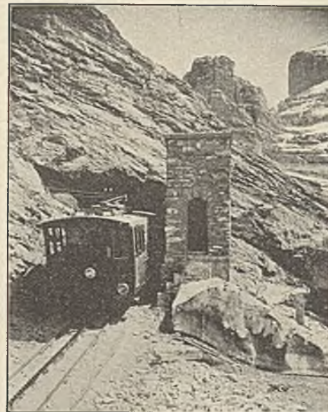
Abb. 4. Jungfraubahn. Einfahrt in den großen Tunnel auf Station Eigergletscher. Juni 1925.
