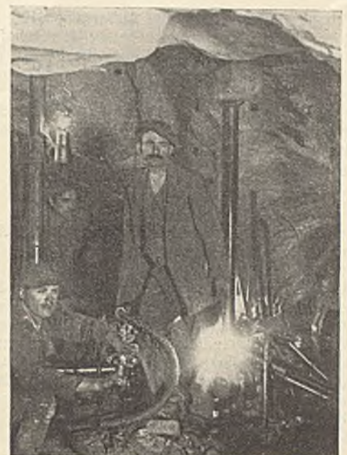
Abb. 5. Arbeit im Stollen.
