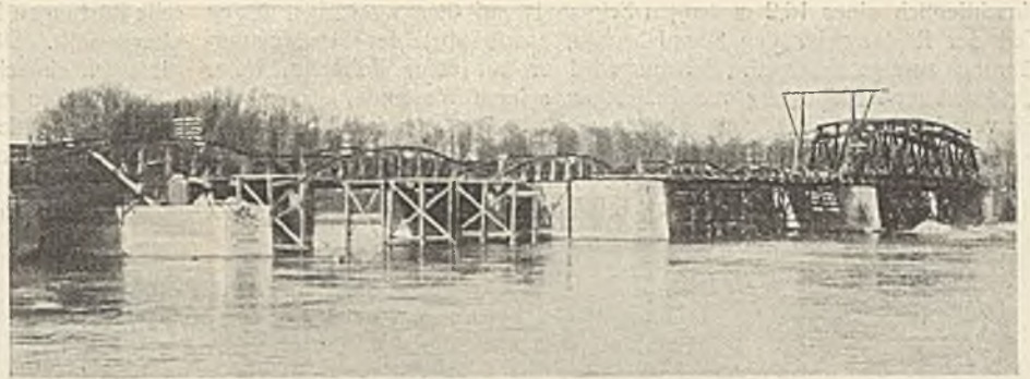
Abb. 29. Aufstellungsbeginn an der Oderbrücke.
