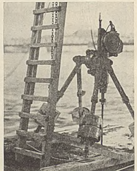
Abb. 46. Bohren der Löcher für die Sprengung der alten Pfeiler.
