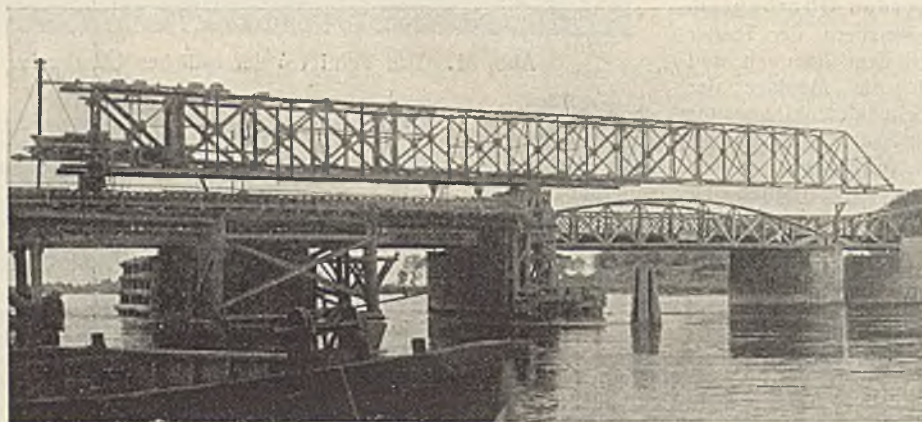
Abb. 35. Hinüberschieben des Rüstträgers über die Schiffahrtöffnung der Oderbrücke, Gleis Berlin—Schneidemühl.
