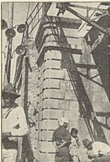
Abb. 27. Schnellbahn Yokohama—Sakuragicho. Verschiebung einer Stützmauer um 50 mm gegen ein unverändert gebliebenes Brückenwiderlager.
