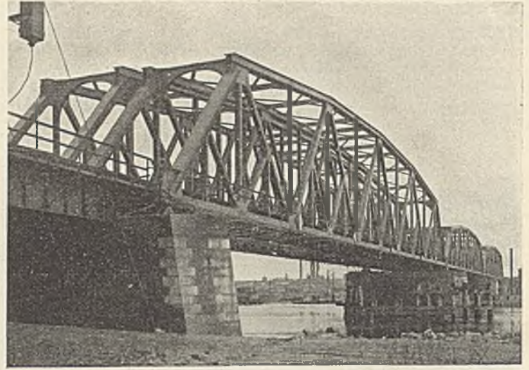
Abb. 43. Die fertige Warthebrücke.
