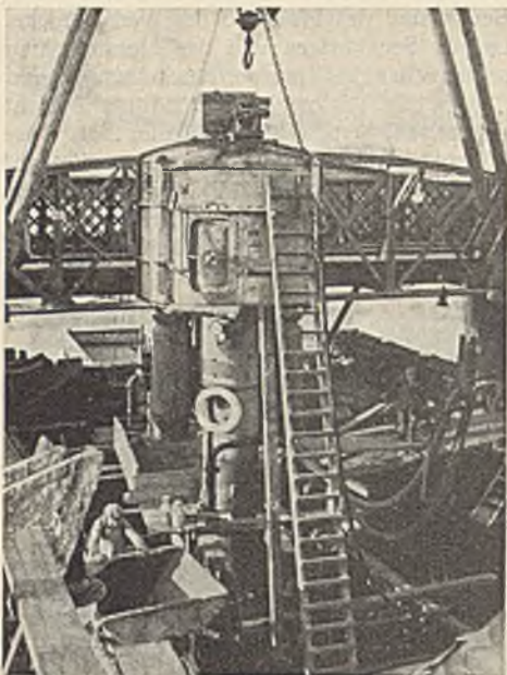
Abb. 23. Absenken des Pfeilers 2 der Warthebrücke.
