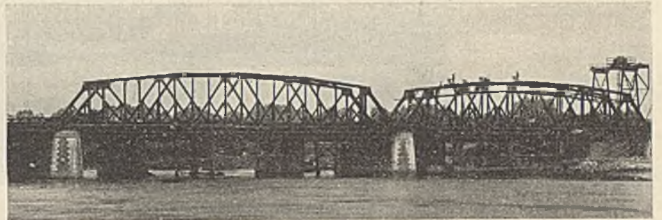
Abb. 31. Das Vernieten der östlichen Überbauten der Warthebrücke.
