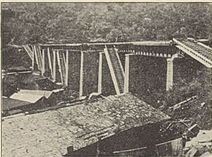
Abb. 6. Eisenbahnbrücke bei Ishibashi, Atami-Bahn.
