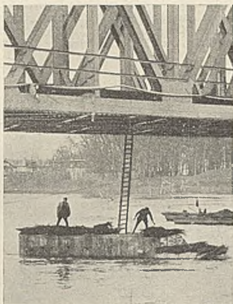
Abb. 47. Einbringen der Sprengladung in die alten Pfeiler.
