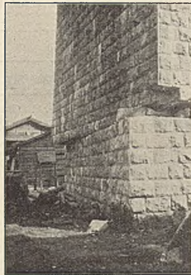
Abb. 7. Pfeiler der Brücke (Abb. 6).
