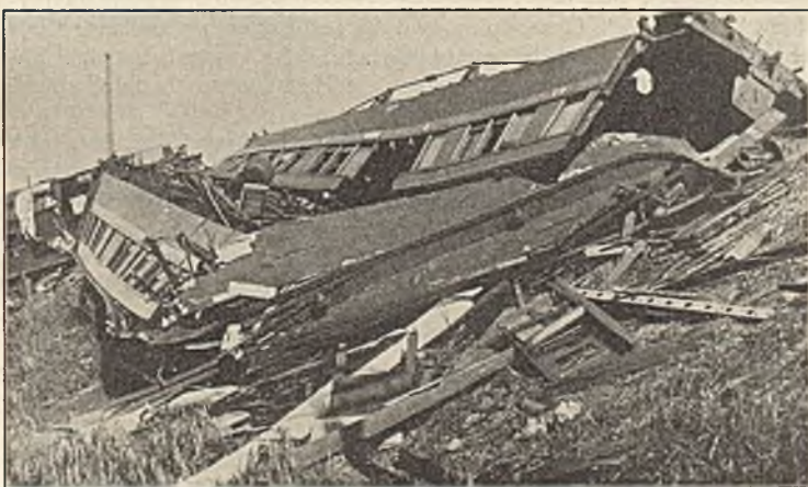
Abb. 14. Abstürzen von Eisenbahnwagen durch Lockerung des Dammes.
