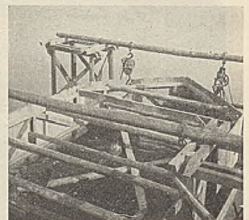
Abb. 27. Warthebrücke. Mauerkasten zum Hochmauern des Pfeilers 2.
