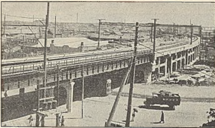
Abb. 10. Stadtbahn-Viadukt Tokio—Uyeno (Betrieb eröffnet 1925).
