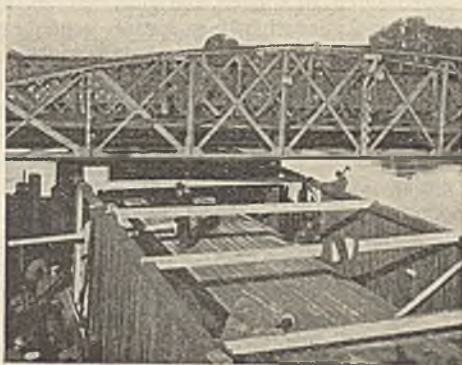
Abb. 18. Oderbrücke. Pfeiler 2. Schalung und Bewehrung des Senkkastens.
