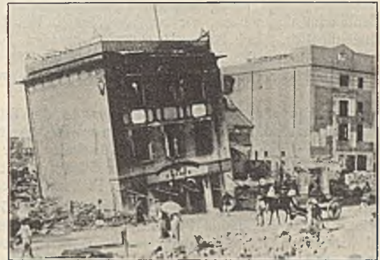
Abb. 4. Schiefstellung eines Hauses durch Ausweichen des Bodens nach einem benachbarten Kanaleinschnitt hin.
