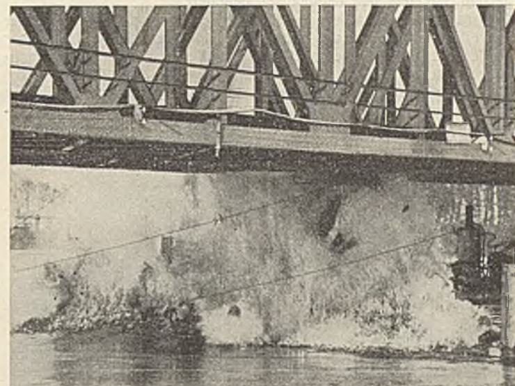
Abb. 48. Die Sprengung eines alten Pfeilers.
