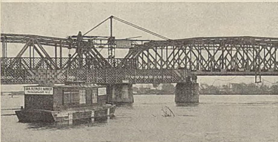
Abb. 45. Ausbau der alten Überbauten der Warthebrücke, Gleis Schneidemühl—Berlin.
