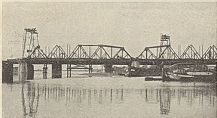
Abb. 30. Aufstellung der beiden östlichen Überbauten der Warthebrücke, Gleis Berlin—Schneidemühl.
