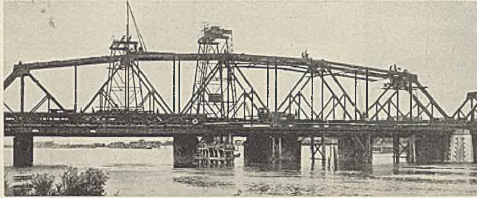
Abb. 34. Das Abnieten des Überbaues von 80 m St.-W. im Gleis Berlin—Schneidemühl der Warthebrücke.
