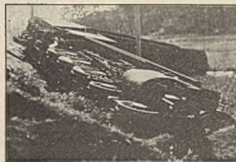
Abb. 15. Abstürzen von Lokomotiven durch Lockerung des Dammes.
