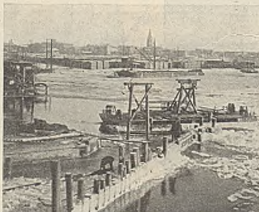
Abb. 26. Warthebrücke. Entfernen der Inseispundwand bei Pfeiler 2.
