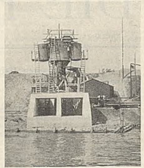
Abb. 10. Luftdruckgründung des Auslasses eines Hauptsammelkanals.
