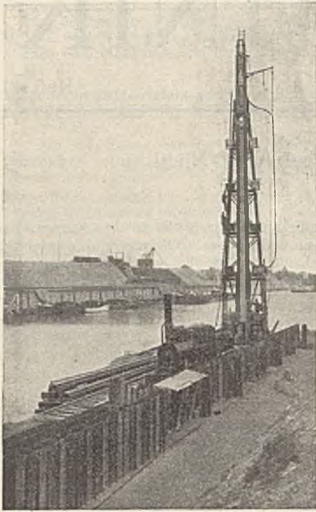
Abb. 9. Herstellen der Kastenprofilwand.
