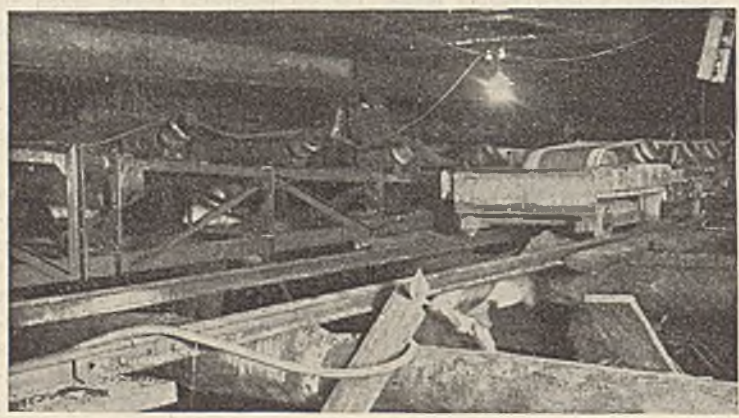
Abb. 6. Ein ortsfestes Aggregat im Ausbau, das bewegliche Band ist bereits an das nächstfolgende ortsfeste Aggregat angeschlossen (Betonieren der Tunneldecke).
