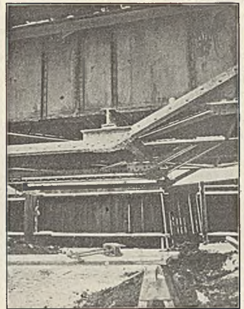
Abb. 6. Untere Hängewerkecke.
