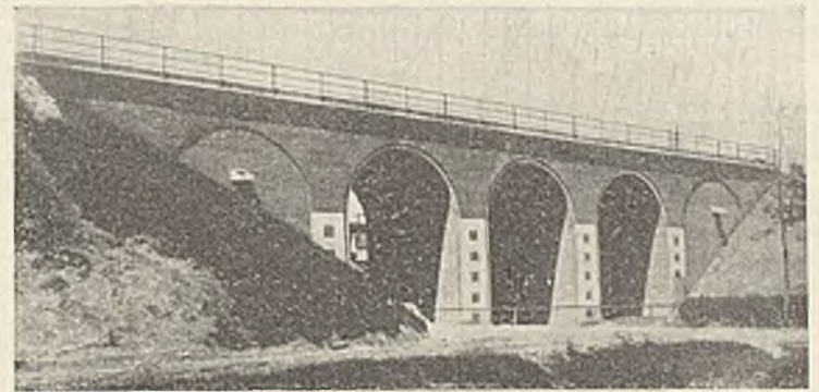
Abb. 9. Ansicht des wiederhergestellten Viaduktes Kláham.
