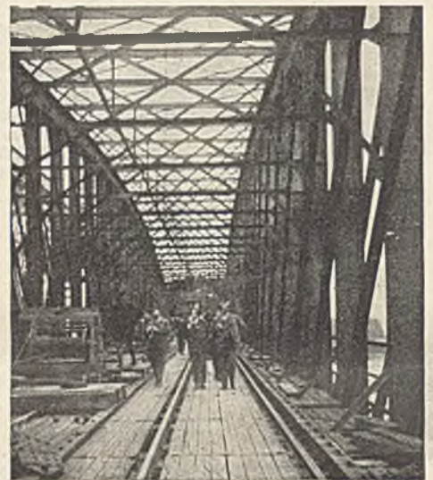
Abb. 22. Gegensatz zum verwirrenden Gitterwerk der alten Brücke.
