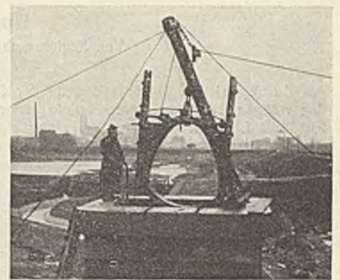
Abb. 8. Einbau des Schützrahmens, dahinter der Überlauf des Auflandebeckens mit Zulaufgraben zur Deichschleuse.
