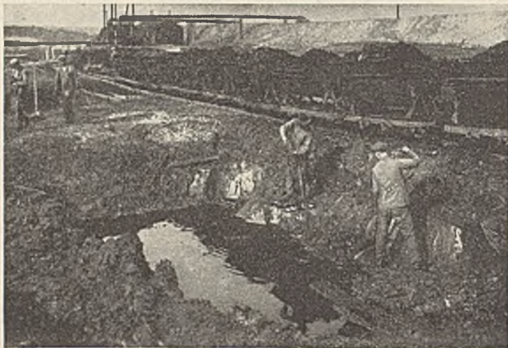
Abb. 5. Ausschachten des Schlammes für den Fuß des neuen Deichs.
