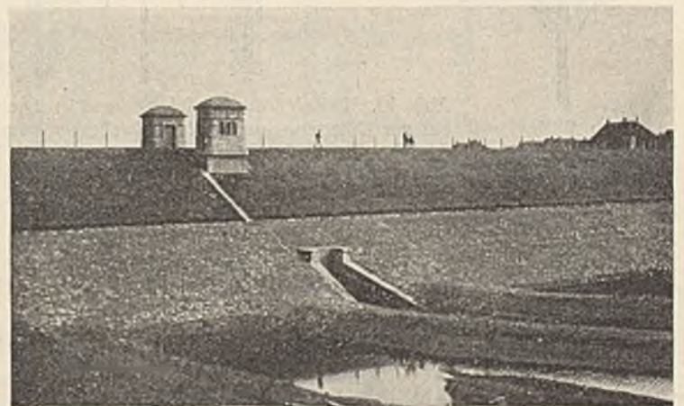
Abb. 11. Der neue Rheindeich mit Schieberhäusern und Binnenhaupt der Deichschleuse.
