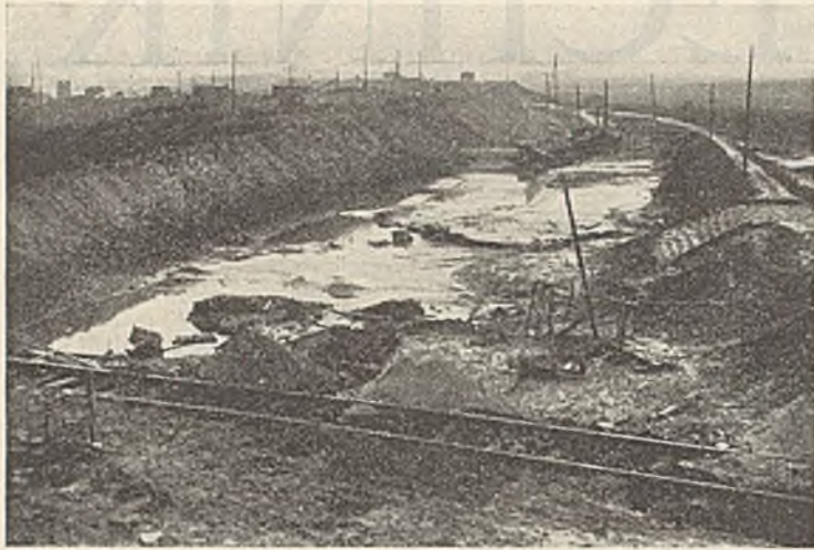
Abb. 4. Links der neue Querdeich in Schüttung, rechts der Hilfsdeich mit Überlauf, im Hintergrunde die Deichschleuse.
